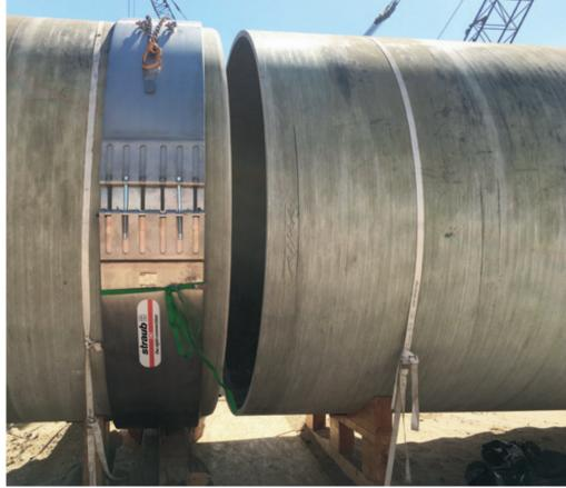
Bandeinlagen einsetzen bei: grossen Rohrendenabständen, Gummi-Quellung , Vakuum, äusserem Überdruck, hohen Temperaturen. Bandeinlagen sind Sonderzubehör und müssen separat bestellt werden.
