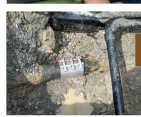
Schadstelle an einer Rohrleitung; schnell und sicher abgedichtet mit STRAUB-REP-FLEX.
